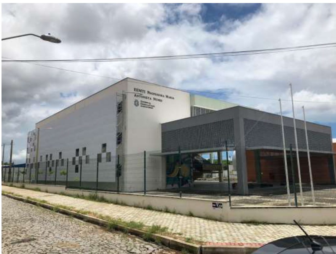
Figura 5 - Fachada da Escola de Ensino Médio Técnico Integrado Professora Maria Antonieta Nunes.
